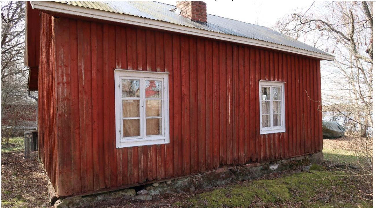
Pohjoinen julkisivu ja kivijalkaa.
