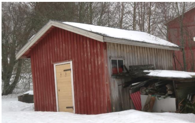
Ulkorakennus/varasto ja käymälä.
