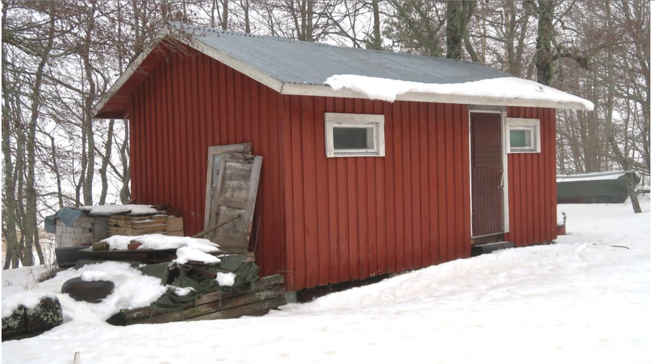
Ulkorakennus/varasto ja käymälä.
