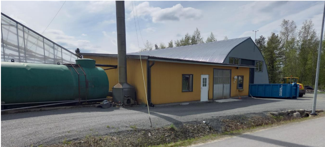
Kuva 5. Nykyinen kasvihuonerakennus MP-alueella.
