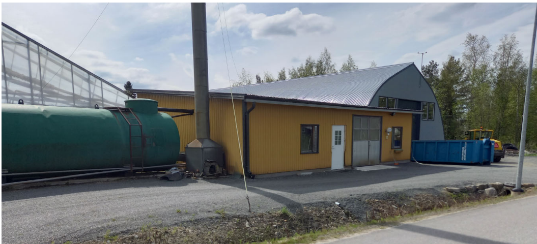
Kuva 5. Nykyinen kasvihuonerakennus MP-alueella.
