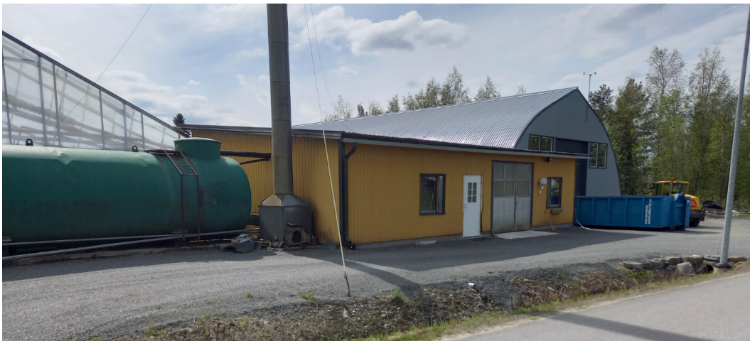
Kuva 5. Nykyinen kasvihuonerakennus MP-alueella.
