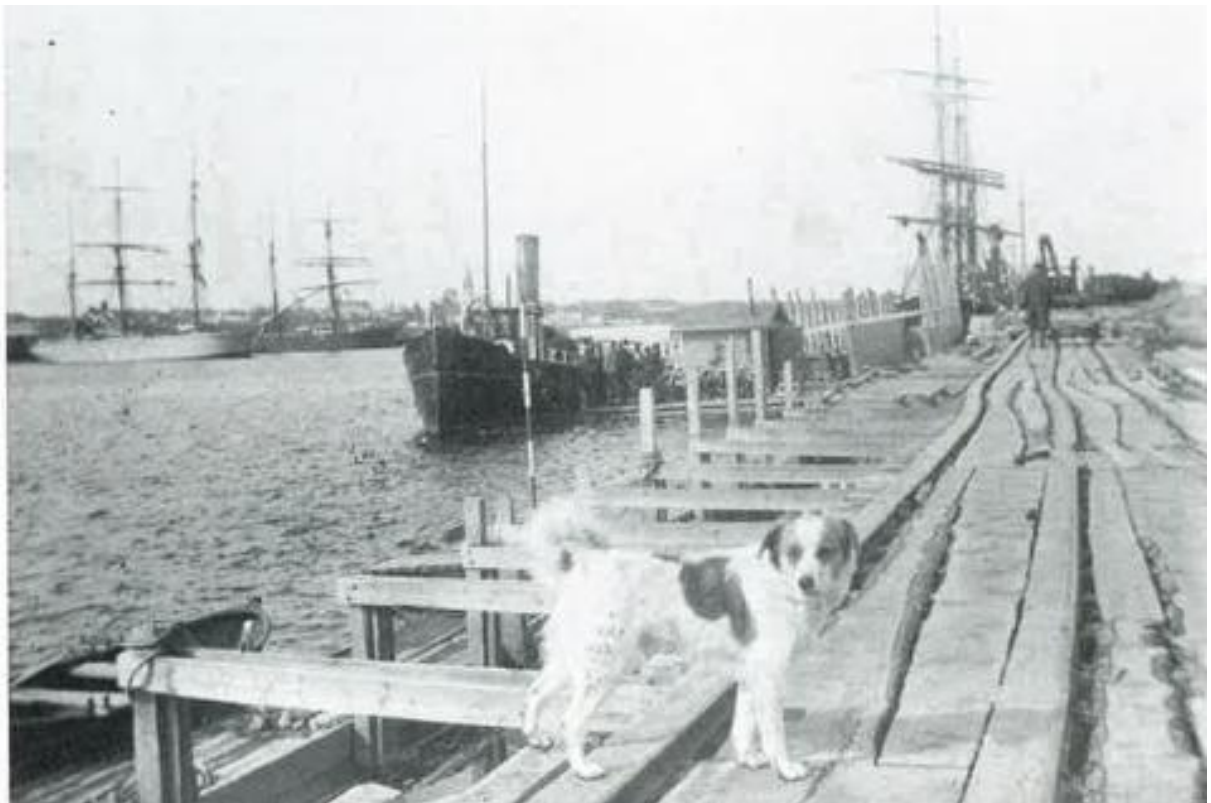
Figur 4-10. Bygge av stenkaj 1913. Fotograferat från söder mot norr. Längst bort till vänster finns barkskeppet CEDIA och vid kajen bogserbåten OIVA. Fotot ägs av Lars Axén, fotograf okänd. (Källa: Norrvik, 1999, s. 545)
