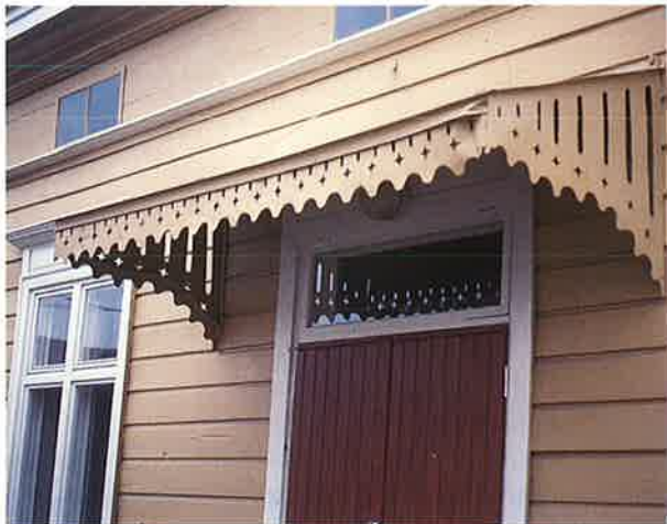
124. Pääsisäänkäynnit on varustettu joskus katoksin, puu- tai teräsrakenteisin. Myös uusiin rakennuksiin voidaan tehdä muotoiluja katoksia. Turvallinen malli on kaareva peltikatos, jossa on yksinkertaiset kannatinraudat.
