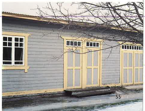
K 116. Talusrakennuksen julkisivu vuosisadan alkupuolelta. Kehysovien "peilit" ovat vinopanelointia. Ovet ovat alkuperäisen piirustuksen mukaiset.
