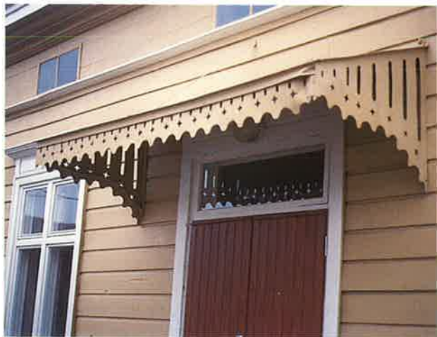
B 124. Ibland har huvudingångarna försatts med skärmtak av trä eller takplåt. Även nya byggnader kan man förse med individuellt utformade skärmtak. En säker modell är det välvda skärmtaket av plåt med enkla stödjärn.
