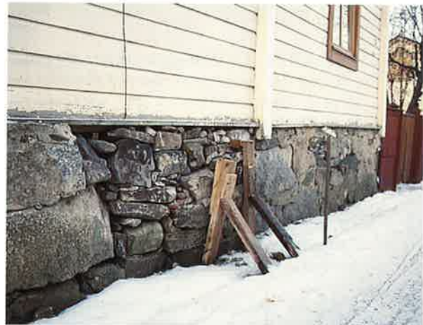
B 88. Den förvittrade grundens skick är i detta fall inte alarmerande. Som förstahjälpsåtgärd duger uppallning.
