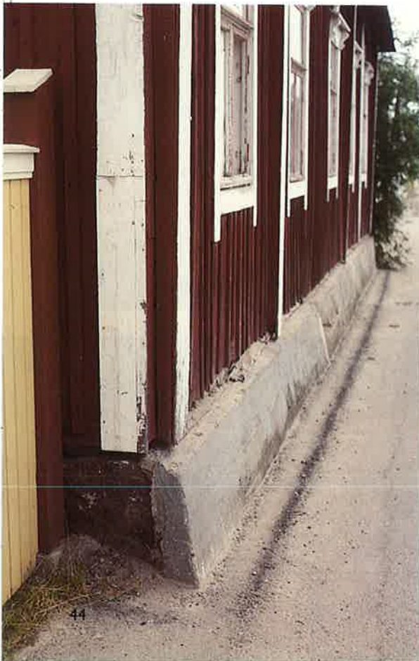
B 88. Den förvittrade grundens skick är i detta fall inte alarmerande. Som förstahjälpsåtgärd duger uppallning.
