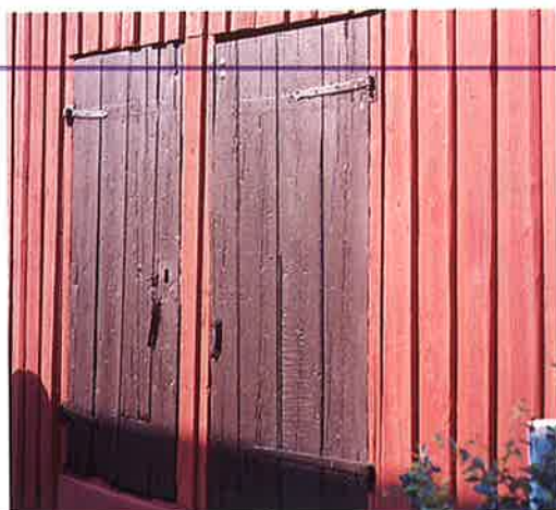
B 115. Enkla plankdörrar i metodistkyrkans uthus. Väggen består av rödmyllad lock-panel.
