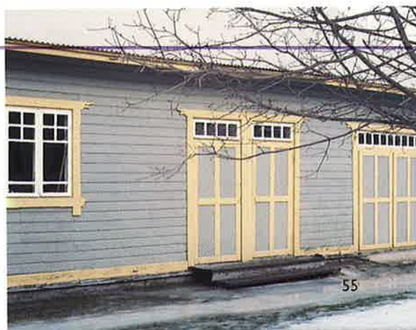
B 116. En uthusfasad från början av detta sekel. Dörrarnas "speglar" består av snedställd panel. Dörrarna har gjorts enligt ursprunglig ritning.
