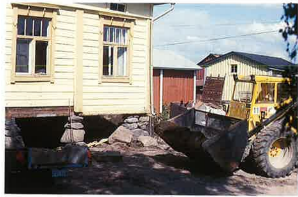
B 87. Timmerhuset hålls uppe endast i knutarna. Det övriga är byggt närmast med tanke på utseendet och som skydd från nordavinden.
